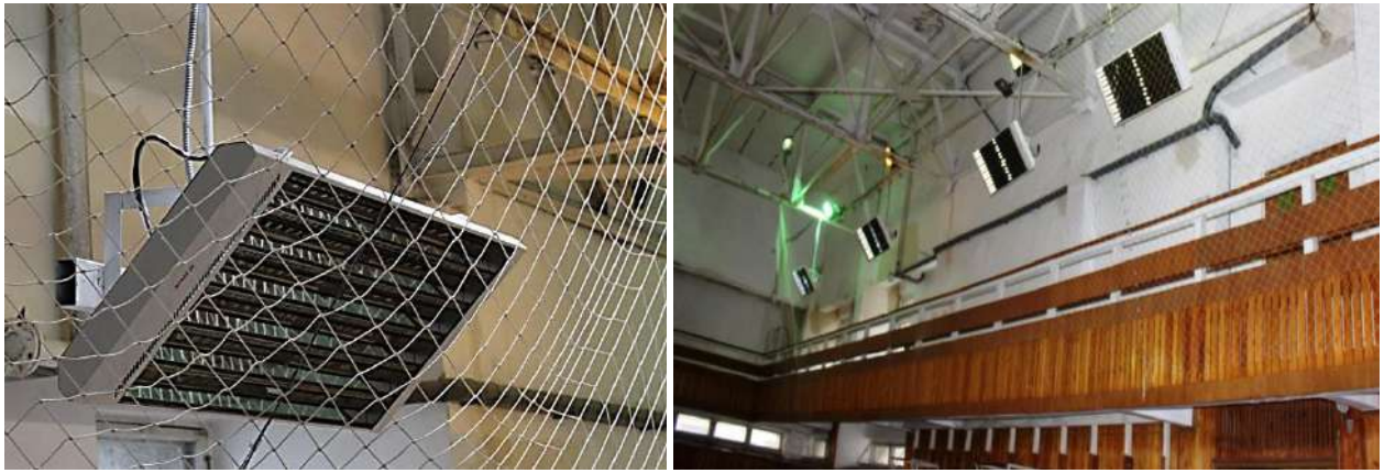
Рис. 6.1. Інфрачервоні обігрівачі у спортивному залі університету
