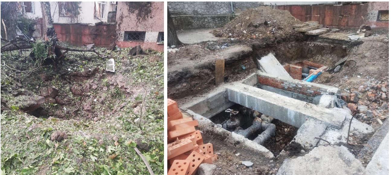
Рис. 2.3.6. Вирва у місці влучання ракети та ремонт зруйнованого вузлу тепломережі внаслідок вибуху
