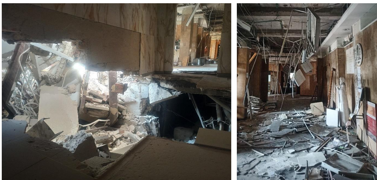
Рис. 2.2.8. Вестибюль головного корпусу університету після вибуху.
