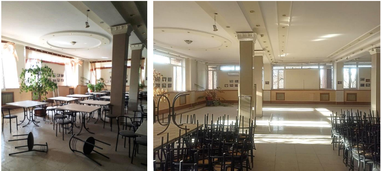
Рис.7.5. Приміщення їдальні пошкодженні від вибуху та після ліквідації наслідків
