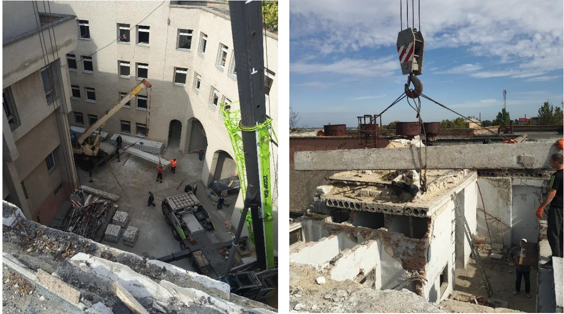
Рис. 2.3.1. Відновлення перекриття на 4-му поверсі.
