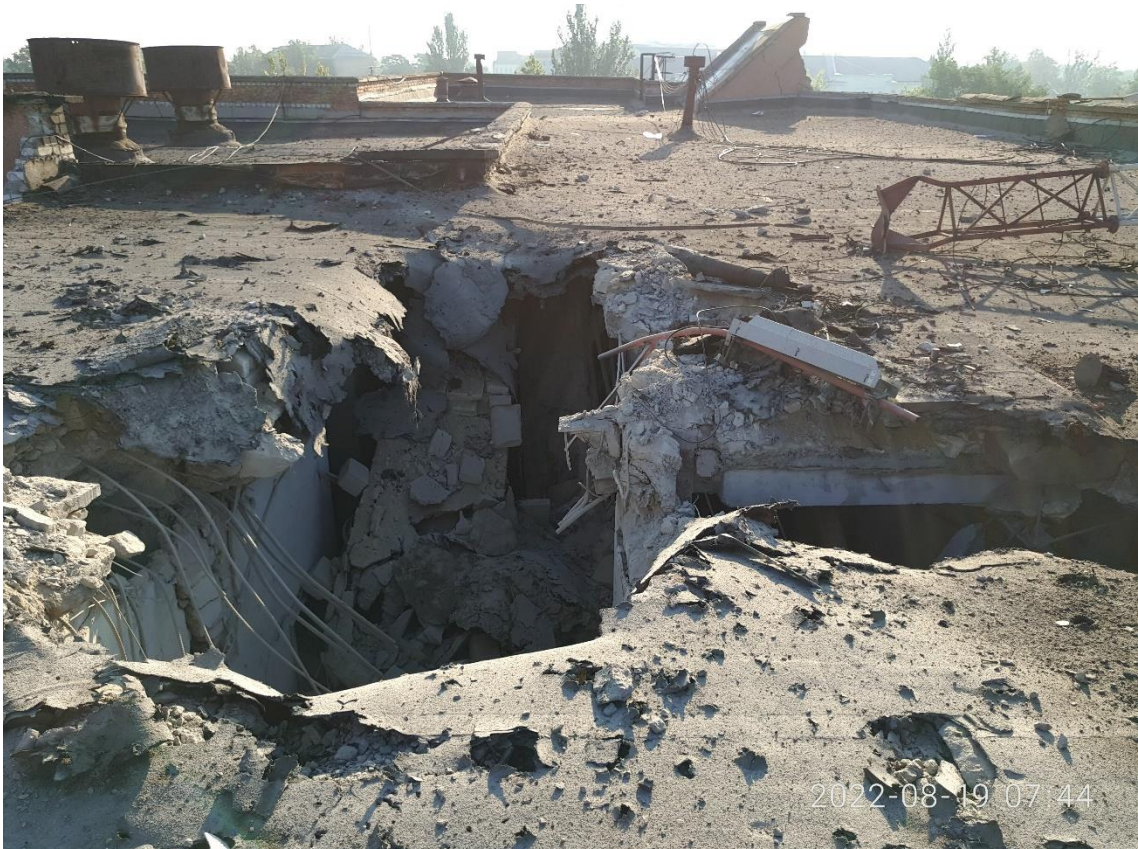
Рис. 2.2.4. Зруйноване перекриття даху головного корпусу.
