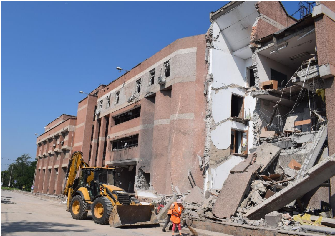
Рис. 2.2.3. Пошкоджений головний корпус університету.
