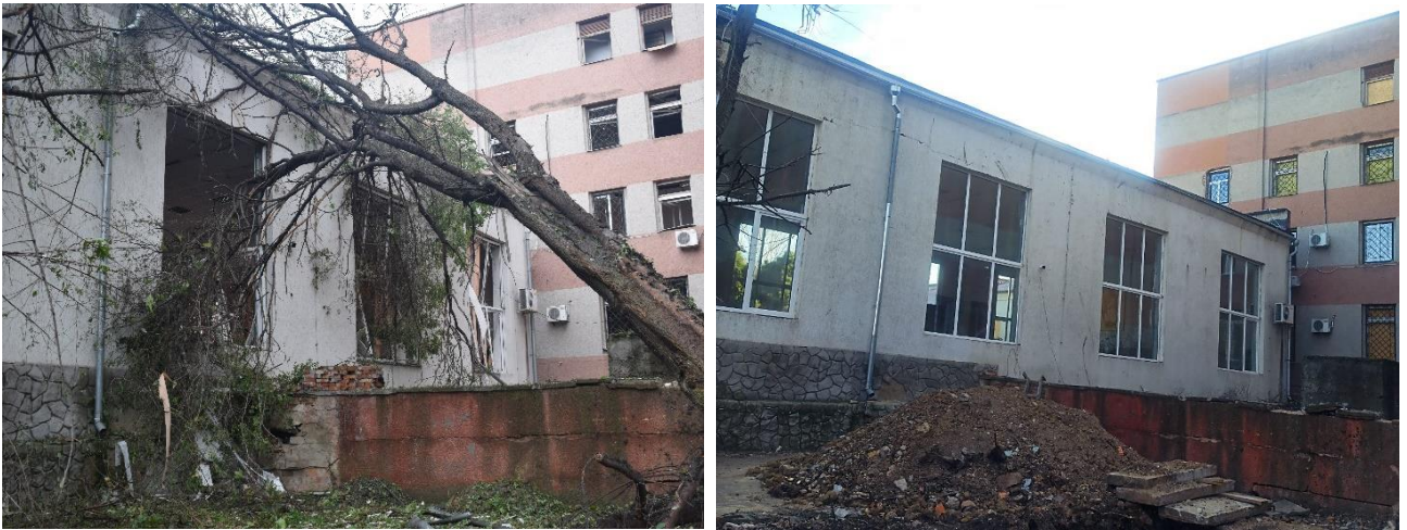
Рис. 2.3.5. Будівля навчального корпусу № 6 «до» та «після» ліквідації наслідків ракетного обстрілу
