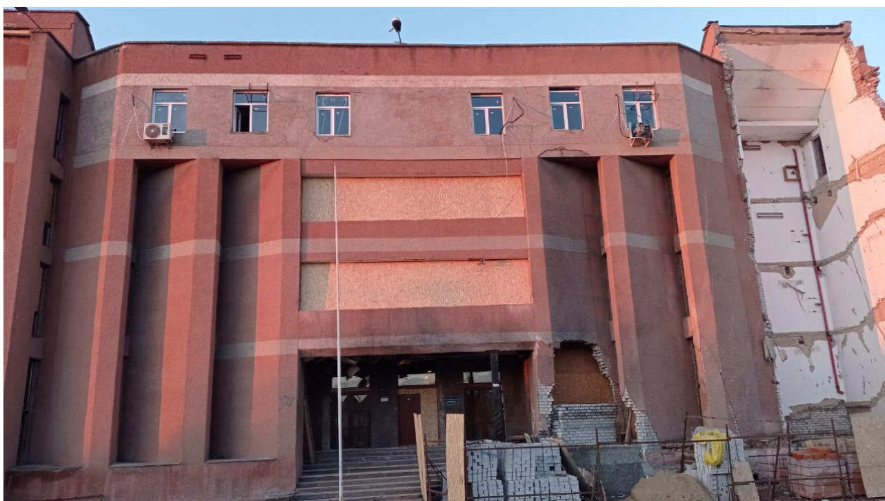
Рис. 2.3.7. Фасад головного корпусу після відновлювальних робіт
