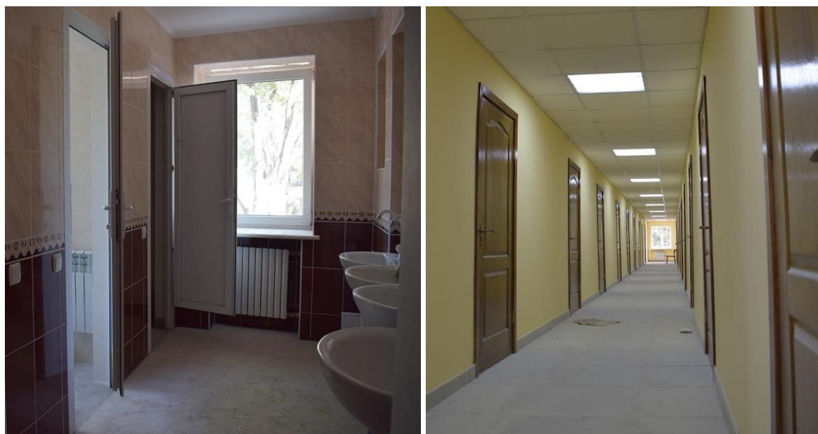
Рис. 6.2. Приміщення університетського студентського гуртожитку № 4 після ремонту
