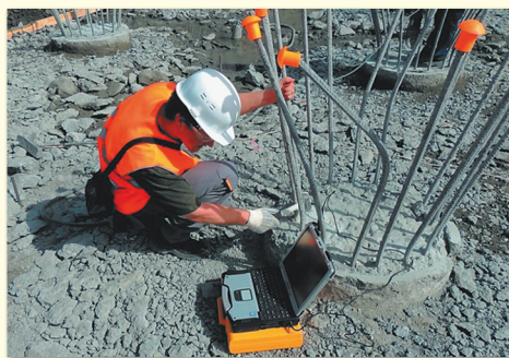
Рис. 2. Тестер ехо-сигналу компанії Piletest для перевірки цілісності пальового фундаменту на будівельних майданчиках із з'єднувачем Fischer LP360 серії Freedom
