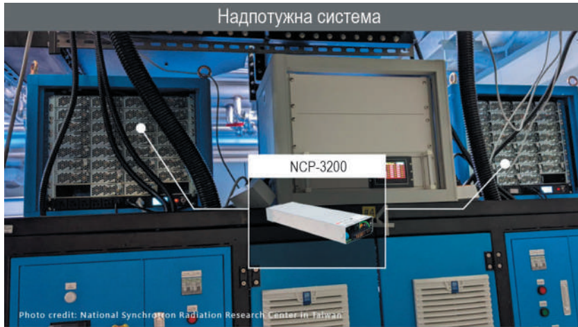
Рис. 3. Приклад використання джерел живлення серії NCP-3200
