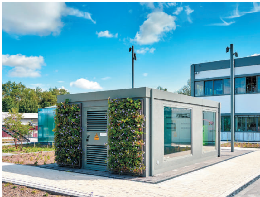
Рис. 5. Тема екологічності була послідовно реалізована при будівництві цієї підстанції
