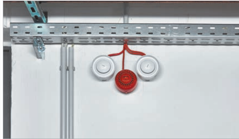
Рис. 2. Сигнальні лінії від панелі керування пожежною сигналізацією ведуть до внутрішньої візуальної та звукової
