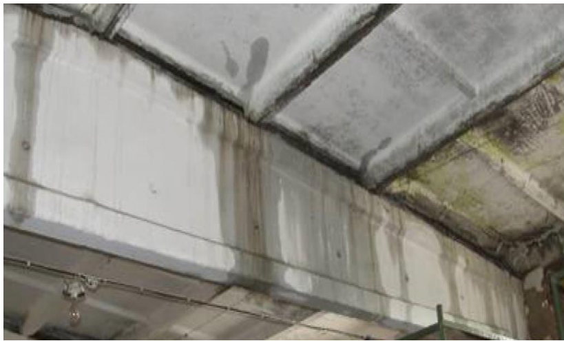
Рис. 1. Замочування двосхилої балки та ребристих плит покриття
