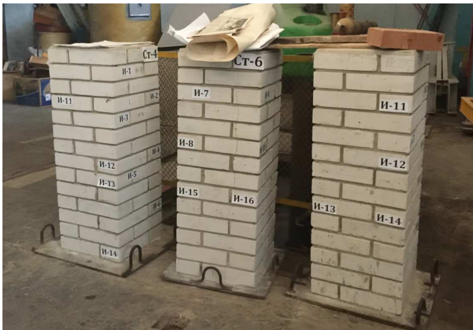
Рис. 1. Поврежденные кирпичные столбы Ст-4, Ст-6 и Ст-7
