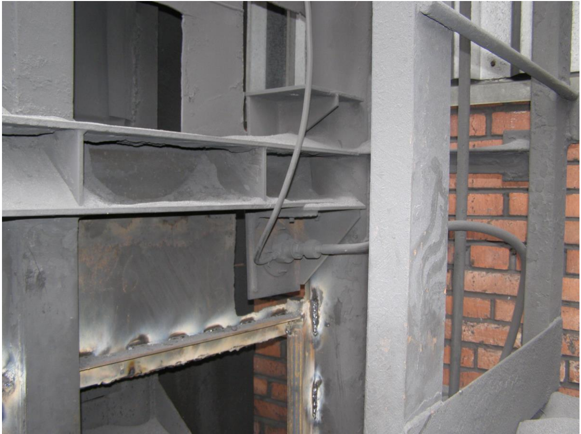
Рисунок 5.4 – Зовнішній вигляд підключеного пірометричного датчика на стороні виштовхування коксу
