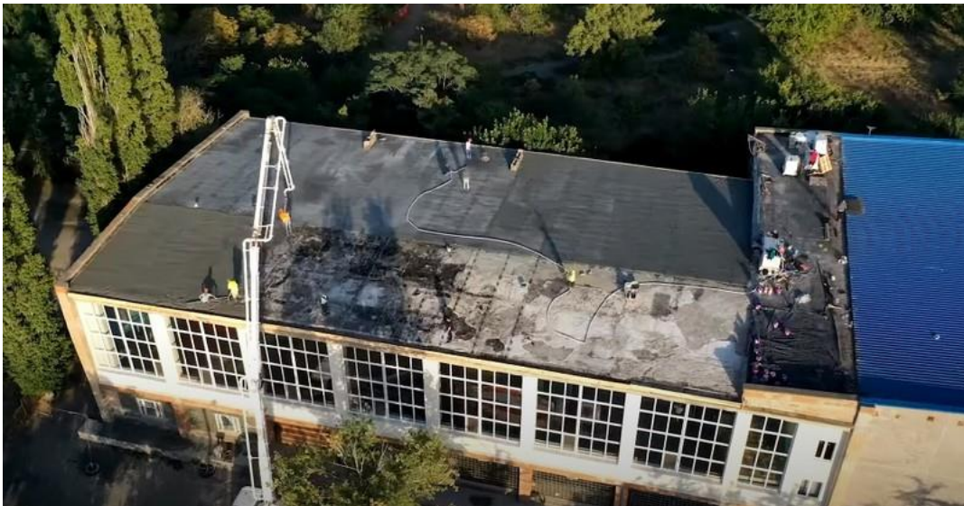
Рис. 6.10. Проведення ремонтних робіт даху Палацу спорту ЧНУ
