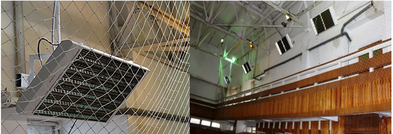
Рис. 6.1. Інфрачервоні обігрівачі у спортивному залі університету
