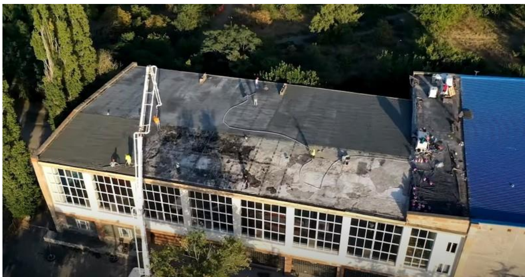
Рис. 6.10. Проведення ремонтних робіт даху Палацу спорту ЧНУ
