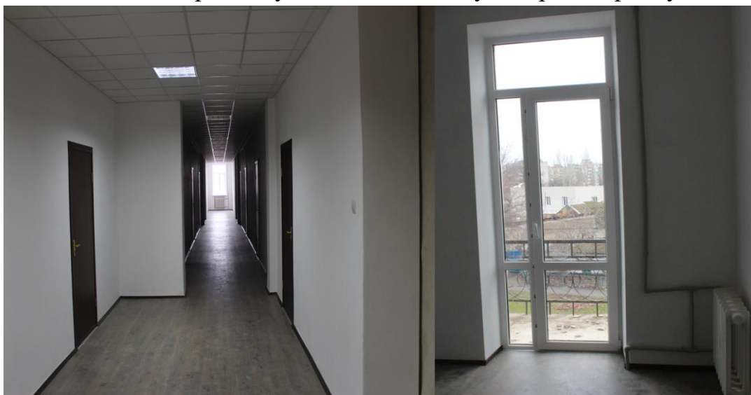
Рис. 6.2. Поточний ремонт 10 корпусу
