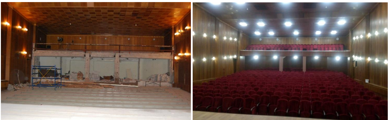
Рис. 6.2. Ремонт актової зали
