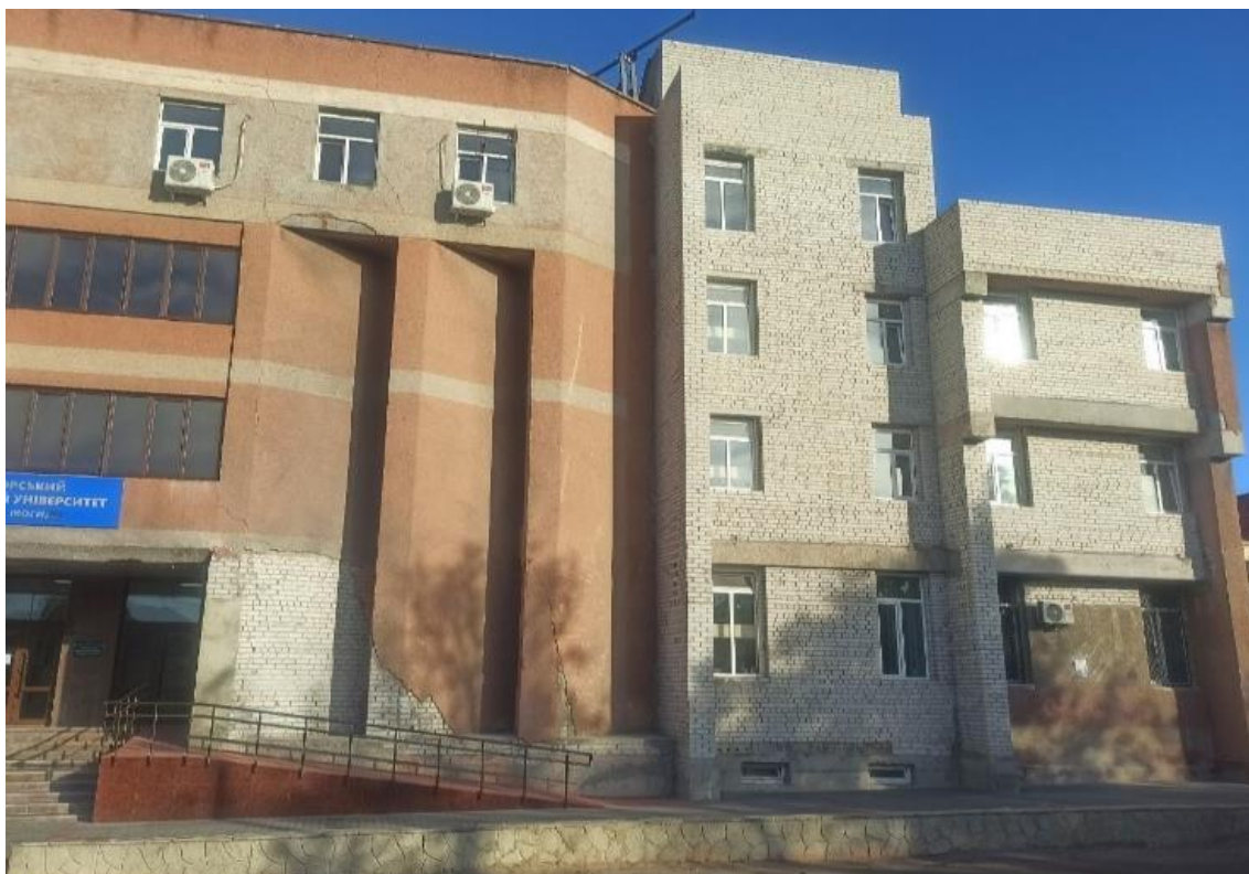
Рис. 2.2.2. Вигляд головного корпусу університету після завершення відновлювальних робіт у вересні 2023 р.
