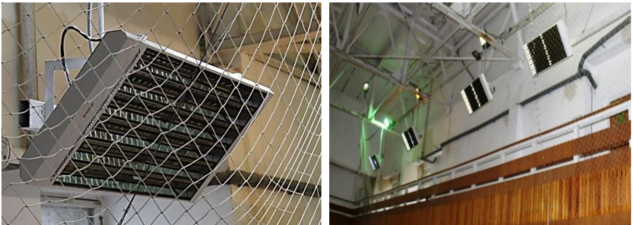
Рис. 7.1.1. Інфрачервоні обігрівачі встановлені в спортивному залі
